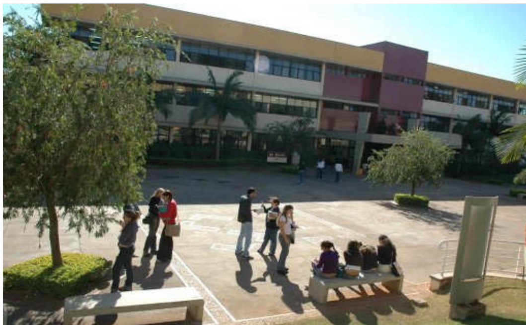
Foto 8 – UNIFRAN – Bloco Bordô – salas de aulas
